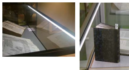
Eclairage LED fixés sur la partie haute du profilé, à l'avant et/ou à l'arrière.
